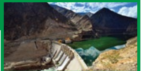
Centrale Idroelettrica Cerro De Aguila Callao
